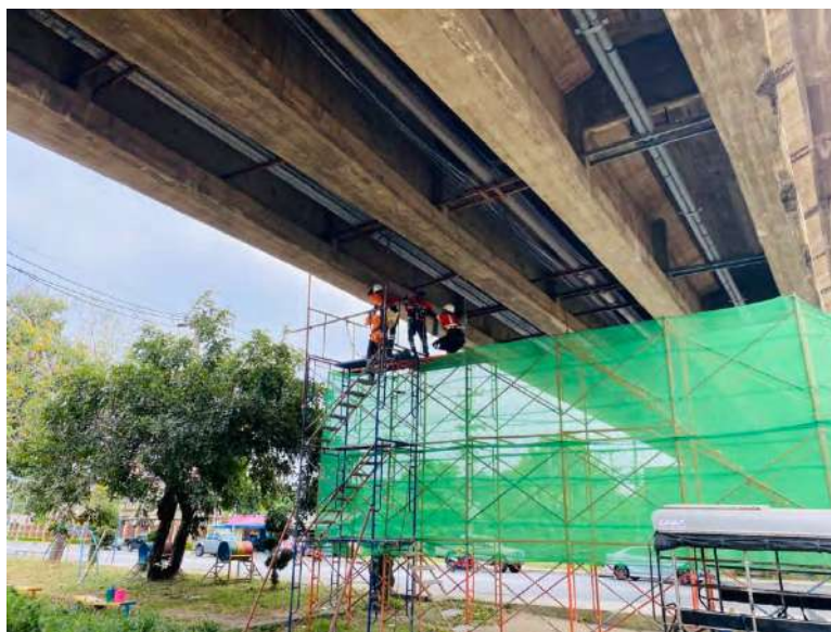
รูปที่ 3-6 การติดตั้งนั่งร้านสำหรับการตรวจวัดแรงดึงในลวดอัดแรง
