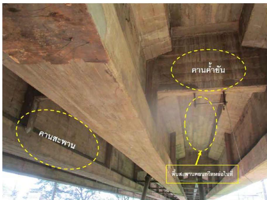
รูปที่ 9-2 พื้นสะพานคอนกรีตหล่อในที่ คานสะพานและคานค้ำยัน
