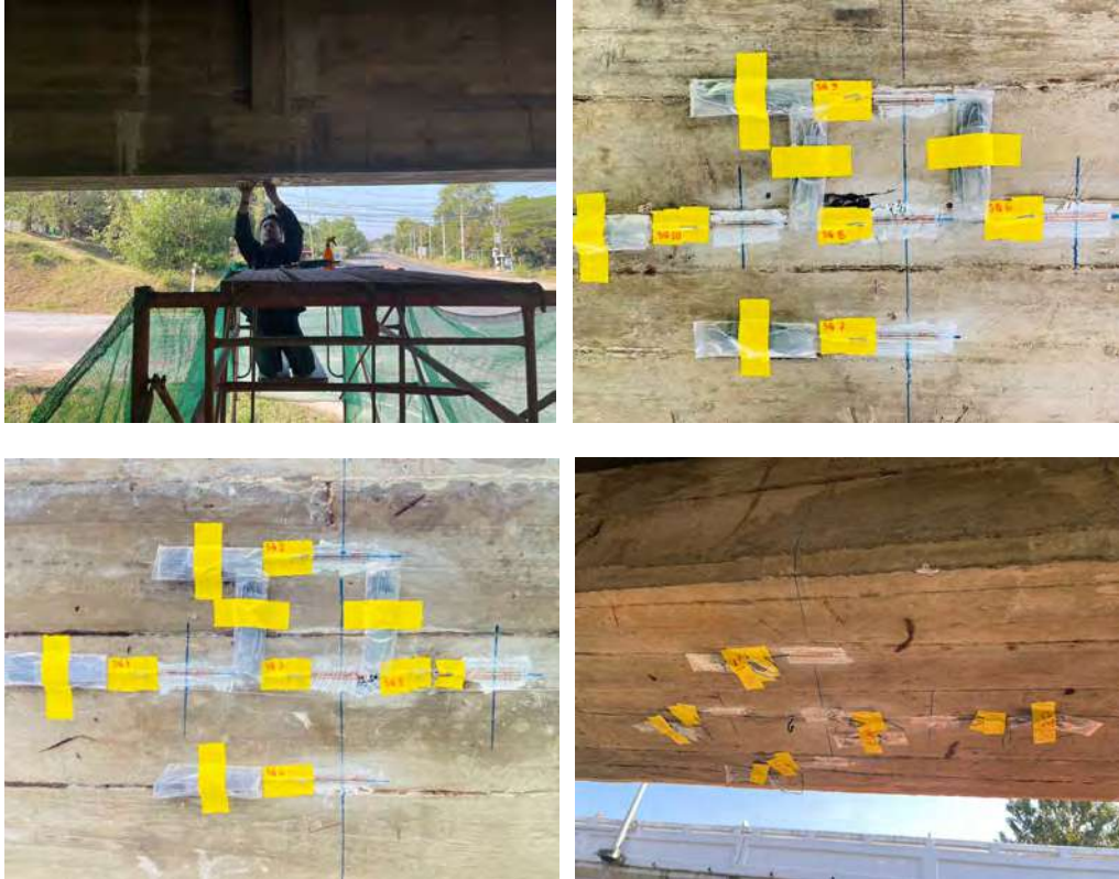
รูปที่ 5-9 ภาพการติดตั้งอุปกรณ์ตรวจวัดสะพาน Span 1
