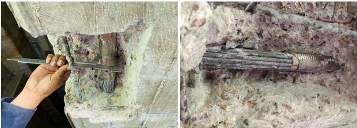
รูปที่ 3-4 การสำรวจและการตรวจวัดหน้างาน
