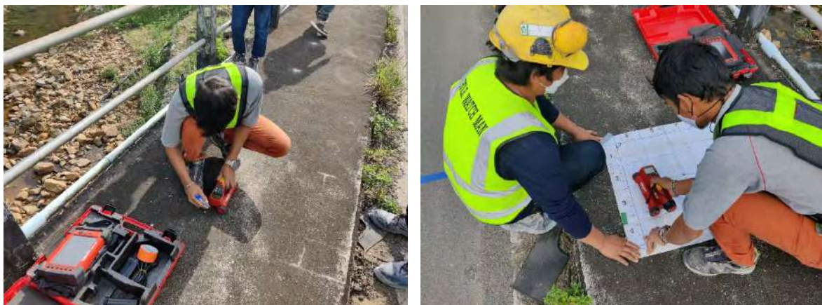
รูปที่ 2-9 ตัวอย่างการสแกนโครงสร้างด้วยเครื่องมือ Ferro Scan
