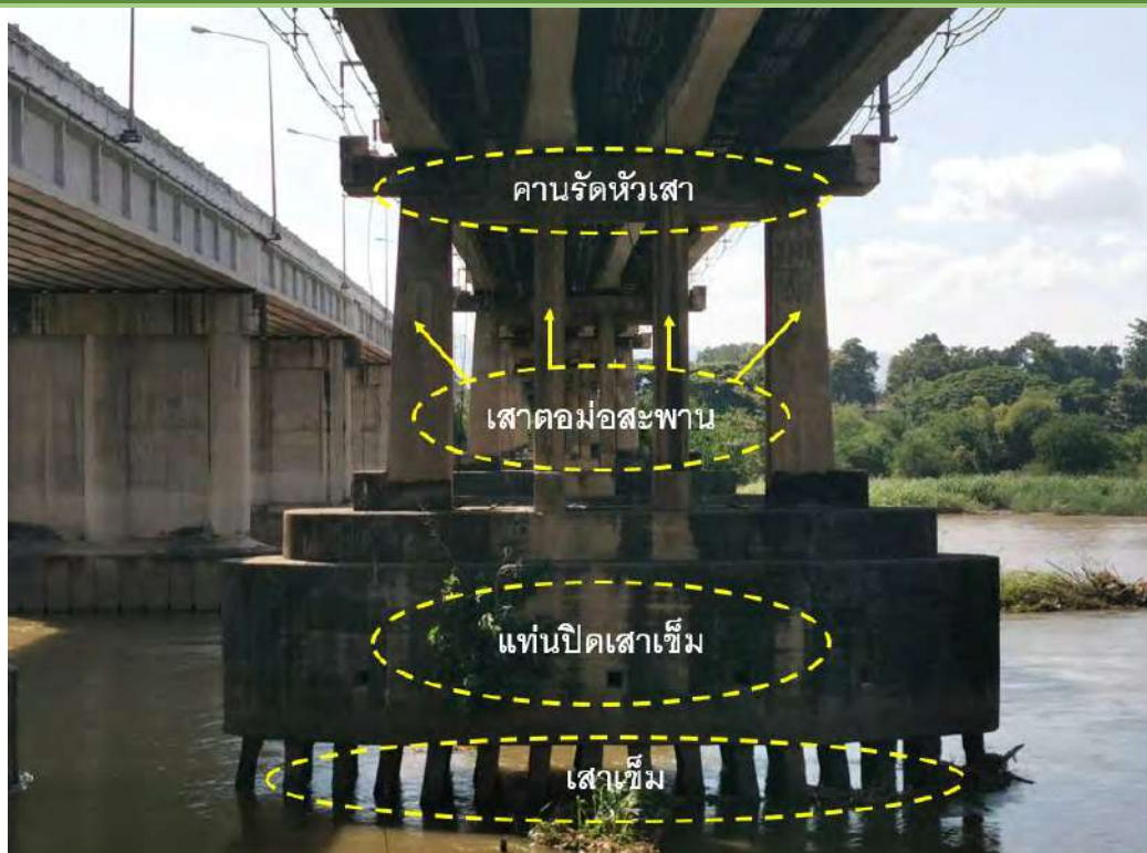
รูปที่ 9-4 เสาคอนกรีตและตอม่อสะพาน
